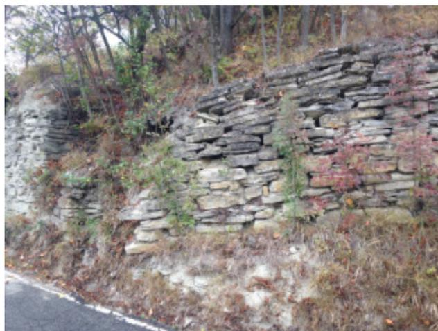
Zona 2) Una ulteriore porzione di scarpata instabile, posta più a valle della precedente ha coinvolto la stabilità di un tratto di muro della lunghezza di 17 metri c.ca, in prossimità dell'incrocio con una stradina campestre. In questo caso la muratura si trova in condizioni instabili e prossima al ribaltamento.
