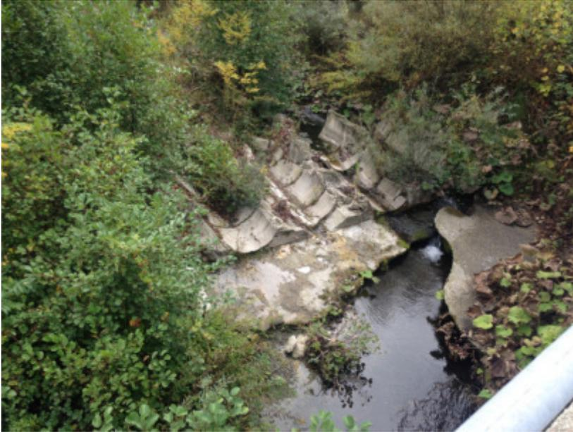
B) corso del rio dei Tre Alberghi : Lungo il corso del rio, per una percorrenza a monte e a valle del ponte sono visibili detriti in alveo costituiti da ghiaia e massi che si sono depositati in vari punti e che ostacolano il libero deflusso delle acque. E' pure presente parecchia vegetazione che ha invaso per buona parte il letto e che necessita di essere tagliata.
