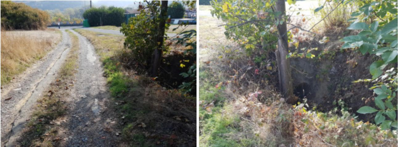
La tubazione risulta di diametro insufficiente a smaltire le acque del rio, specie in occasione di eventi metereologici estremi (nubifragi) con conseguente straripamento e riversamento delle acque sulla sede stradale. Si ritiene necessario intervenire con la sostituzione del tubo con tubazione di maggiore diametro.
